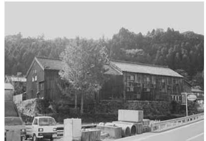
図51 バイパスからの全景
