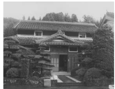
図16 主屋玄関部分
