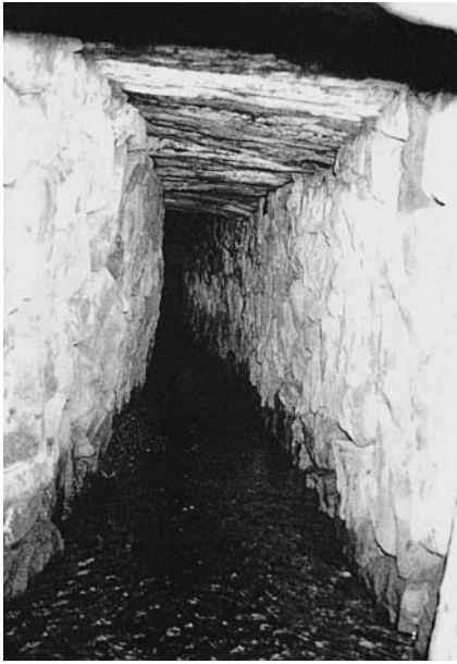
写真6 三村用水隧道の内部
