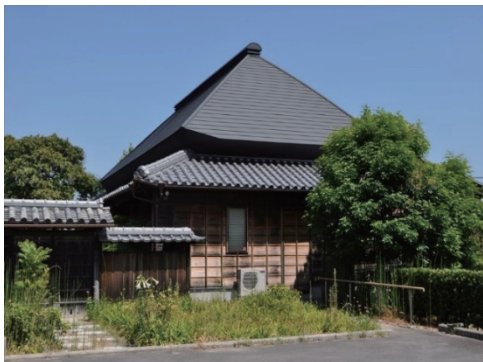
写真-17 外観写真
