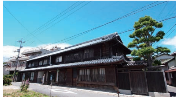
写真-7 町家型商家の主屋
