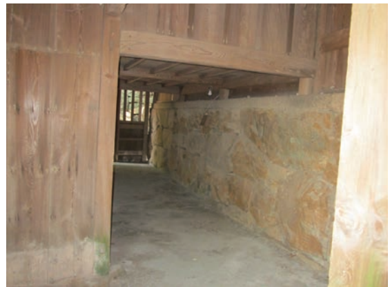
図 4 妙見神社本殿（渡り廊）
